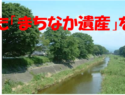
付け替られた芹川
