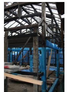
足軽屋敷（改修中）
