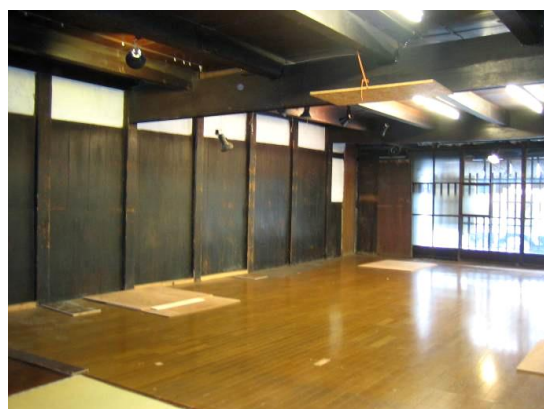
耐震改修前の力石の内部
