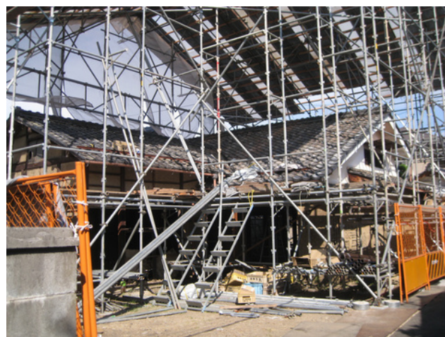
解体修理中の善利組足軽屋敷(旧磯島家住宅)
